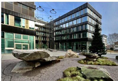
Ehemaliges Postareal Freiburg, D Projektzeitraum: 2013-2020 Fläche: 9.000 m 2
