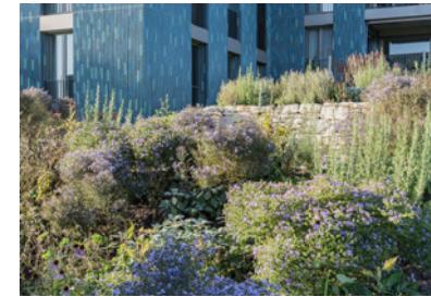
Wohnsiedlung am Südhang Brugg, CH Projektzeitraum: 2017-2019 Fläche: 3.500 m 2 Planungspartner: Sollberger Bögli Architekten
