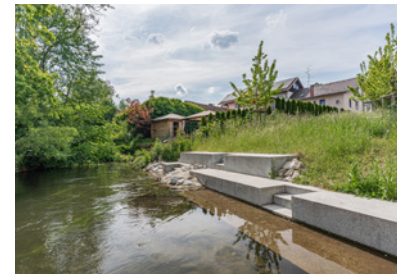
Ortsumitte Margaretenstraße Krailling, D Projektzeitraum: 2015-2022 Fläche: 16.700 m 2
