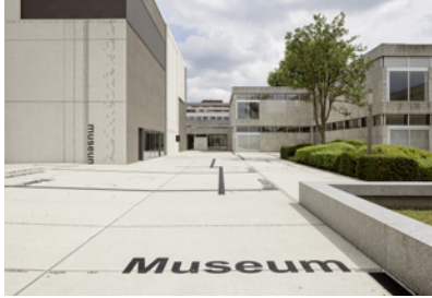
Freiraumgestaltung Erweiterung Moderne Galerie Saarbrücken, D Projektzeitraum: 2014-2017 Fläche: 13.000 m 2 Planungspartner: Kuehn Malvezzi Architekten, und Michael Riedel
